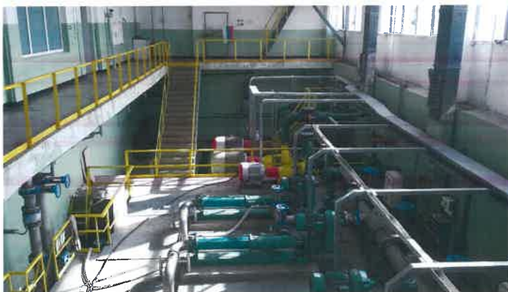
Фигура 2 - Съществуваща помпена станция за сурова утайка
