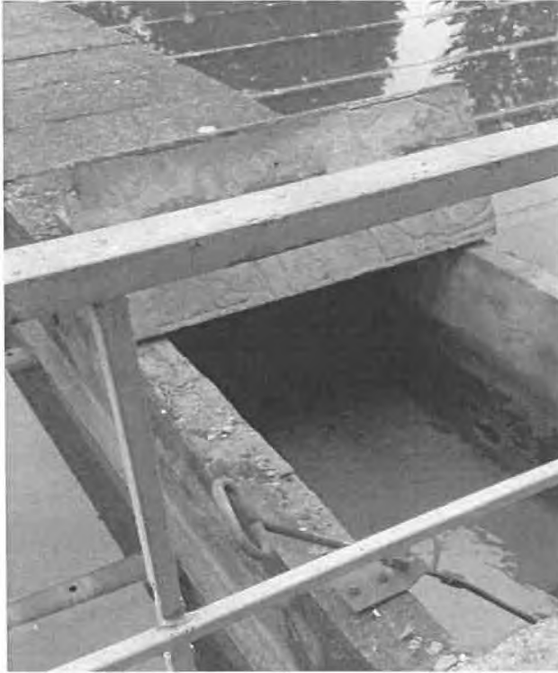
Фиг.3 Канал за избистрена вода – от избистрители тип „Пулсатор“ към бързи пясъчни филтри
